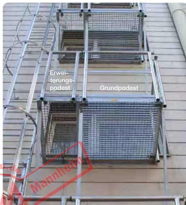
Abb. Best.-Nr. 60941 + 60942, Befestigung mit Sonderkonsolen.
